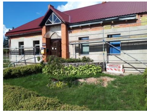
Lūk, tā jau ir vēsture! Sarkanie, “Kūlīšu” ēkas ķieģeļi tiek aizsegti ar siltināmo materiālu.
